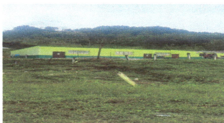
Foto1: SE OBSERVA CAMBIO DE LAMINA A LAMINAS TROQUELADA
