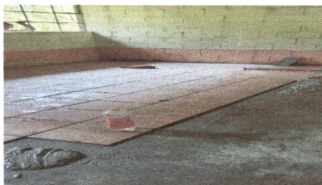
Foto 4: SE OBSERVA EL CAMBIO DE PISO CERAMICO DEL MODULO I
