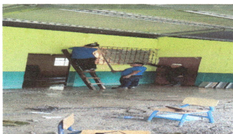
Foto 3: SE OBSERVA LA INSTALACION DE VENTANAS DE UNO DE LOS MODULOS.
