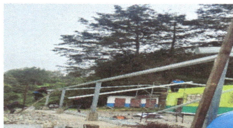
Foto 2: SE OBSERVA LOS TRABAJOS DE SUSTITUCION DE COSTANERA DE MADERA A METALES
